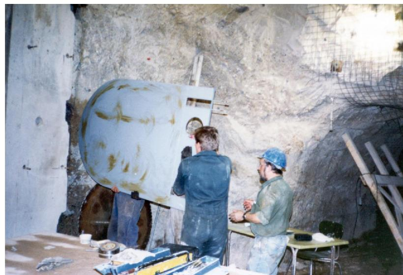
**Slika 20. Ugradnja jastuka u vertikalni prorez (Godar-E-Landar, 1992)**
