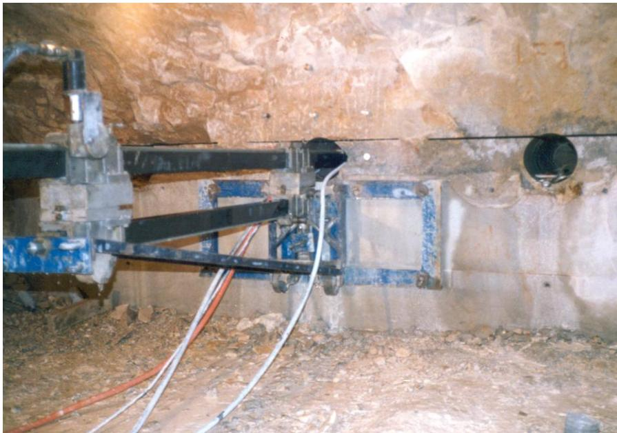
**Slika 19. Rezanje srednjeg (aktivnog ) proreza. Pasivni prorez su izrezani. Vide se i reperi za mjerjenje pomaka na površini iskopa (Karun 3, 1993).**
