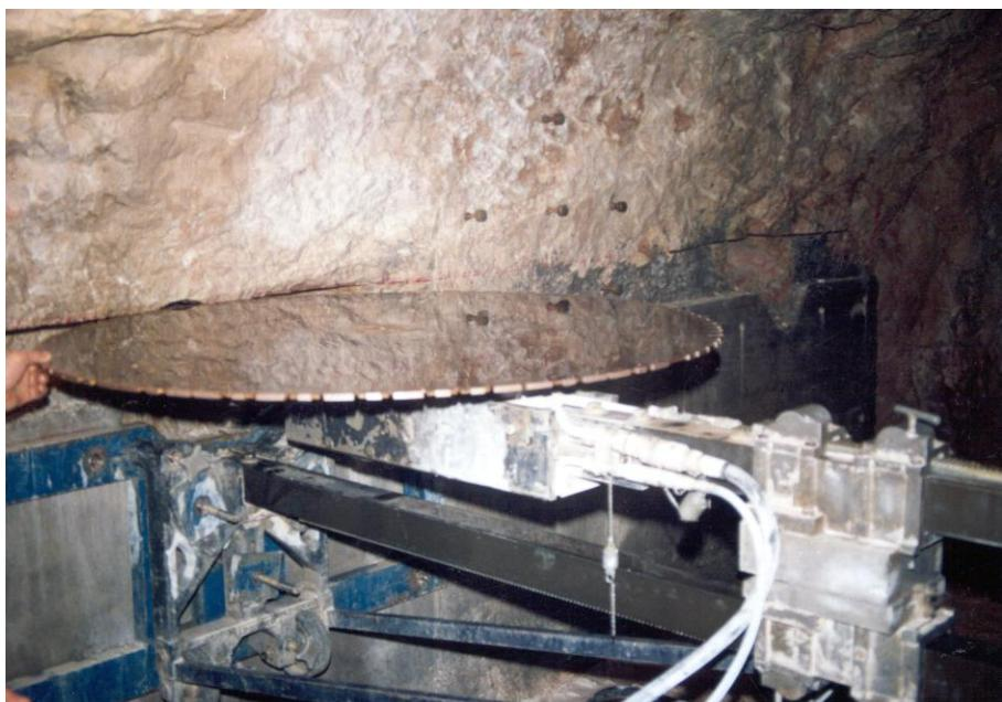
Slika 18. Rezanje lijevog pasivnog proreza. Vide se reperi za mjerjenje pomaka u zoni aktivnog proreza (Karun 3, 1993).
