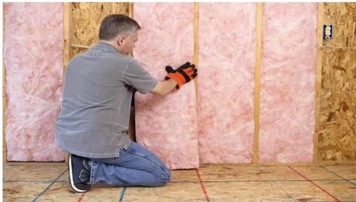
Slika 8. Postavljanje termoizolacije [6]
