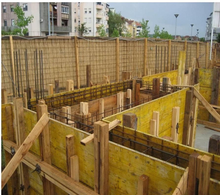
Slika 7. Postavljanje oplata za betoniranje zidova [5]
