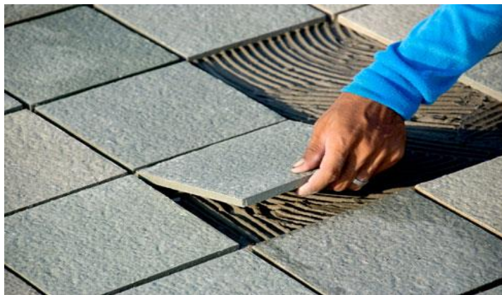
Slika 16. Postavljanje keramičkih pločica [11]
