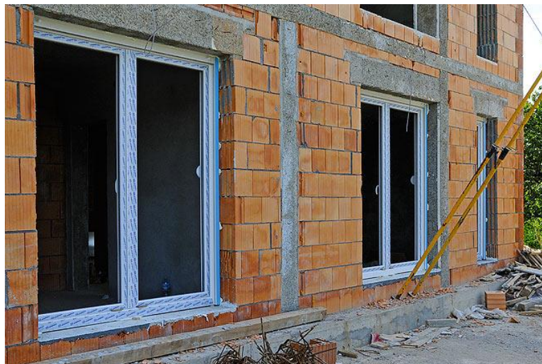
Slika 16. Izolacija propusnih mjesta na vanjskom plaštu kuće
