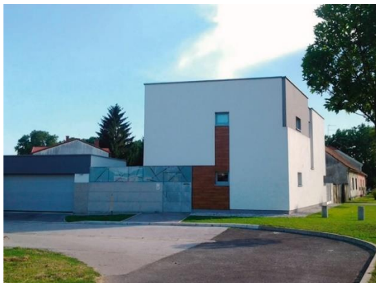
Slika 1. Pasivna kuća u Varaždinu, Ulica Ante Starčevića,18
