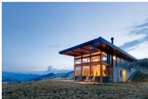
Slika 6. Položaj pasivne kuće prema jugu sa većim ostakljenim površinama
