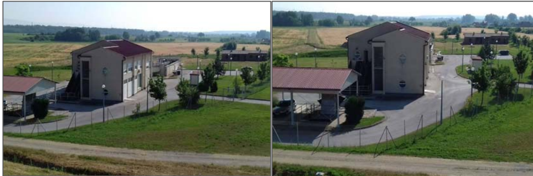
Slika 9. Centralni uređaj za pročišćavanje otpadnih voda u Požegi
