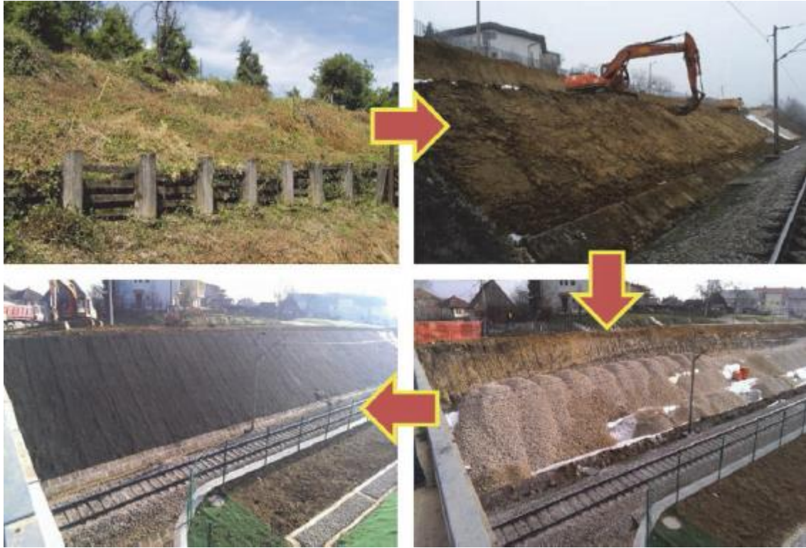
Slika 25. izvedba sanacije klizišta na dionici D (Udović i sur. 2014)
