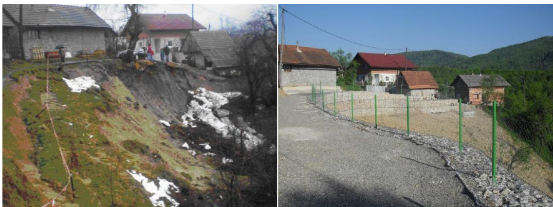
Slika 27. Klizište prije i poslije sanacije (Soldo i sur. 2012)
