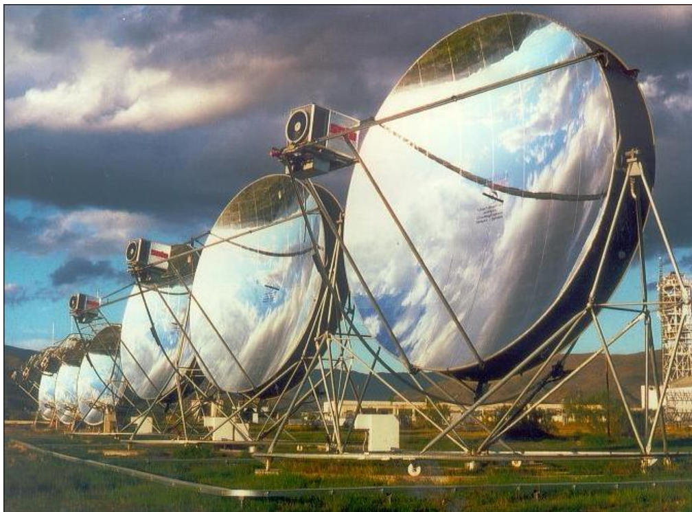
Slika 8. Solarni parabolični tanjuri [4]
