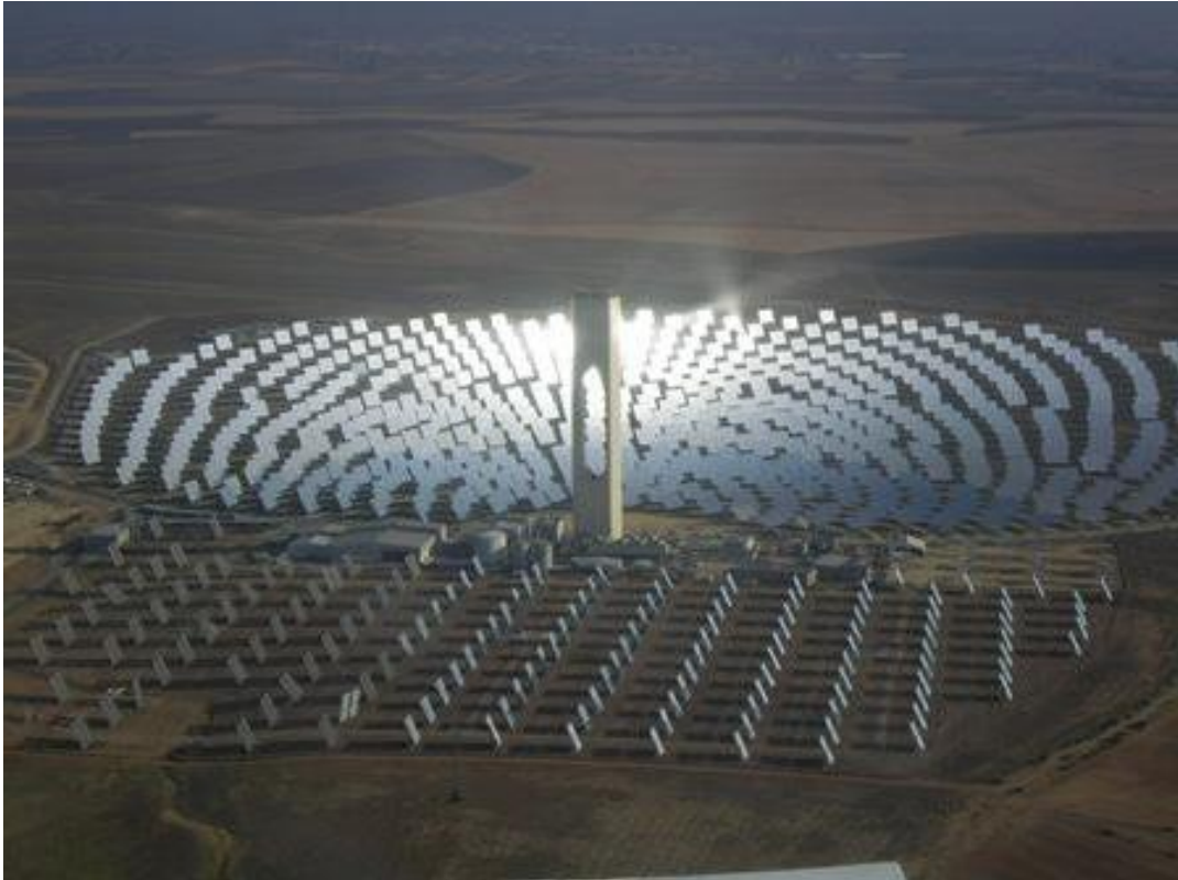
Slika 7. Solarni toranj kraj Seville, Španjolska [4]
