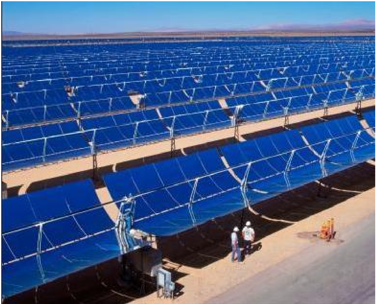
Slika 6. Parabolični kolektori,Kramer Junction,Kalifornija [4]
