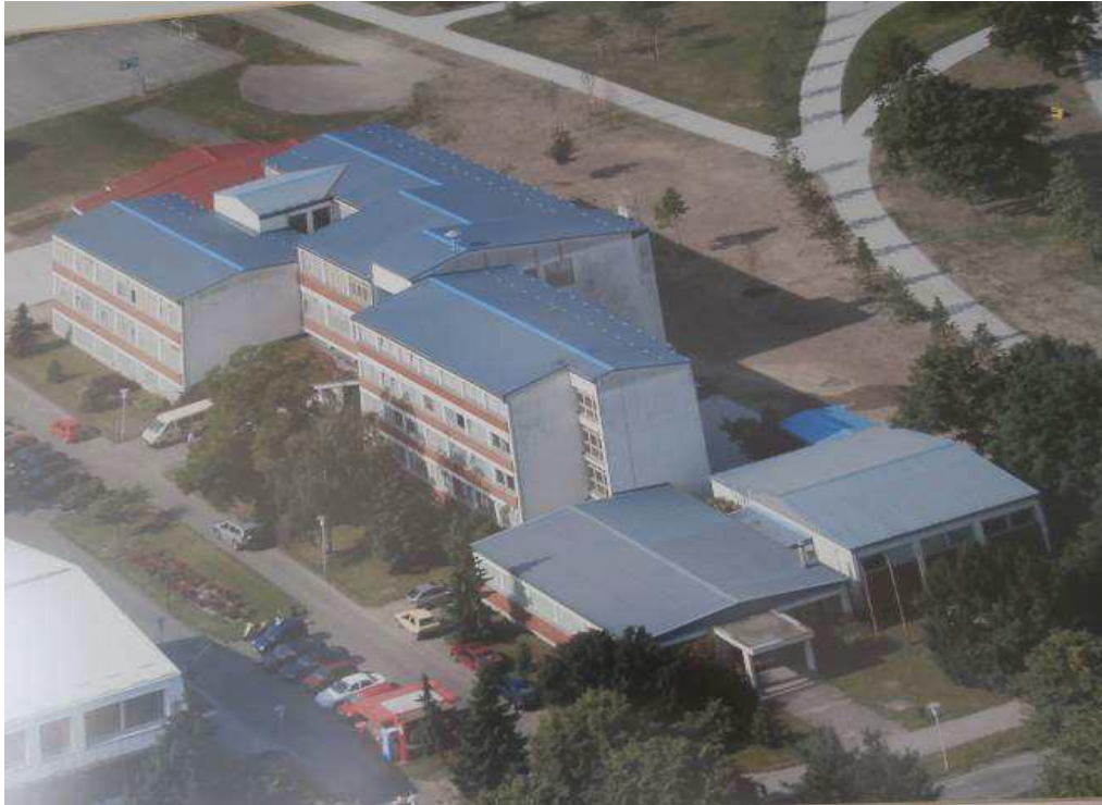
Slika 11. Zgrada Geotehničkog fakulteta u Varaždinu [6]
