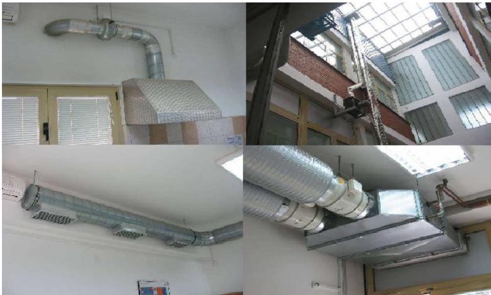
Slika 8.Odsisnanapa (lijevo, gore), kanali za odvod otpadnog zraka (gore, desno), kanalni razvod svježeg zraka (dolje, lijevo) i toplovodnizagrijač (dolje,desno) u laboratoriju u zgradi Geotehničkog fakulteta u Varaždinu [6]
