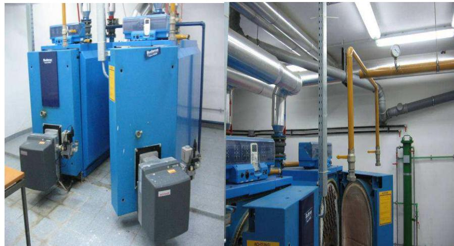
Slika 7 Toplovodni kotlovi (lijevo), dovod plina ikotlovska automatika (desno) u kotlovnici zgrade Geotehničkog fakulteta u Varaždinu [6]
