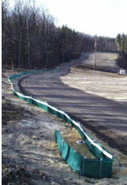
Slika 20. Privremena ograda za zaštitu vodozemaca od čvrste neprozirne plastične folije visine 40 cm, zajedno s gustom mrežom (LACON, 2014).
