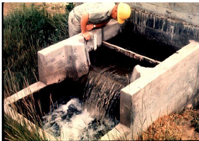
Slika 17. Cipolettijev preljev [20]
