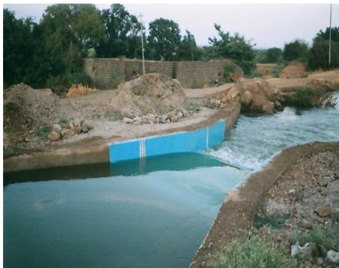
Slika 19. Mjerni kanal sa suženjem [22]
