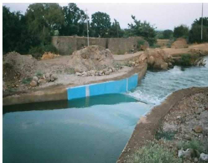
Slika 19. Mjerni kanal sa suženjem [22]
