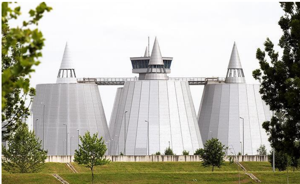
Slika 4. Postrojenje za anaerobnu obradu mulja na UPOV Zagreb [15]
