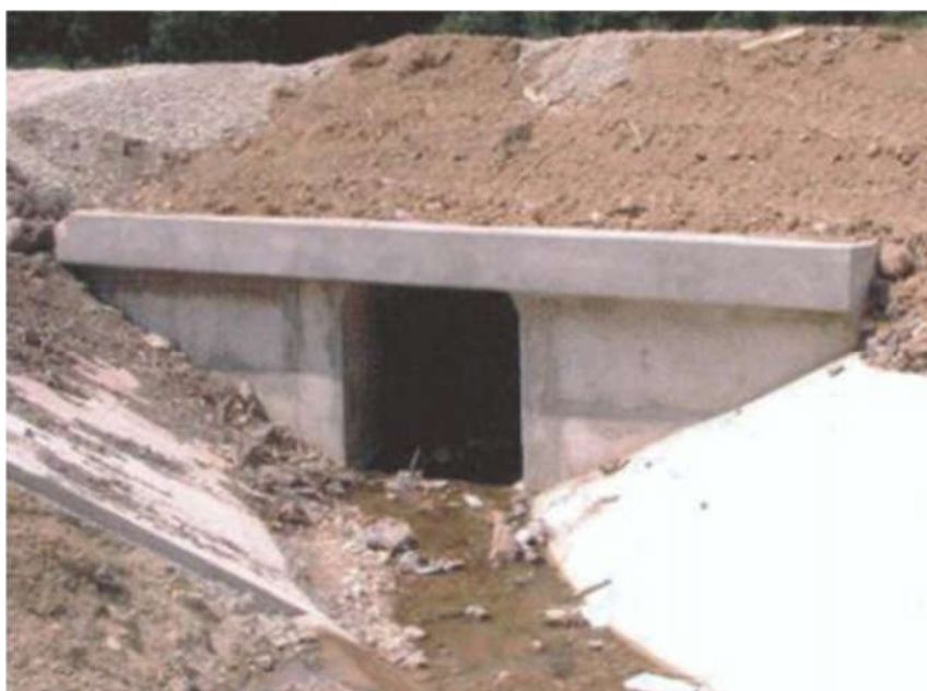
Slika 11. Pločasti betonski propust [3]
