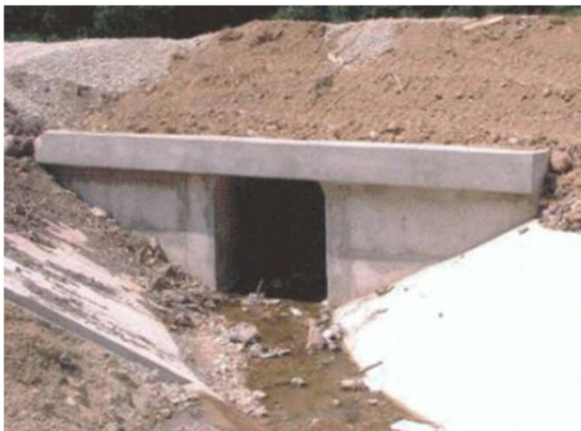
Slika 11. Pločasti betonski propust [3]
