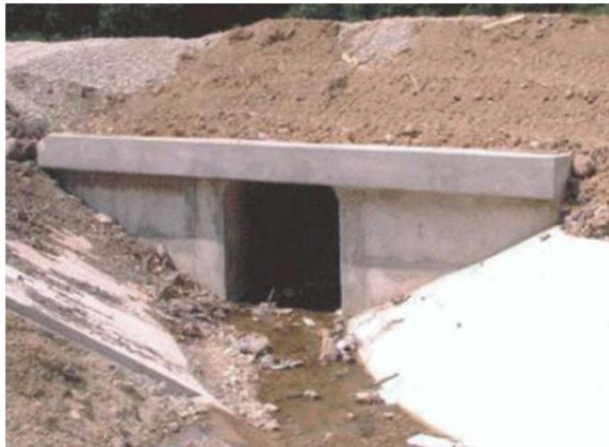
Slika 11. Pločasti betonski propust [3]
