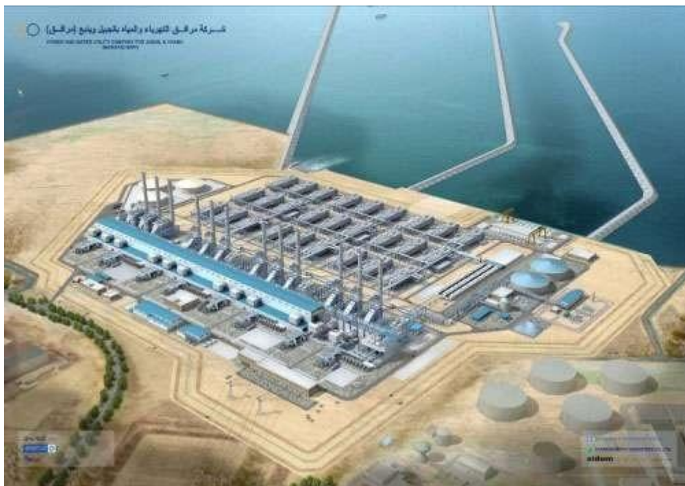
Slika 13. Prikaz postrojenja za desalinaciju vode napajano fotonaponom. (Saudijska Arabija) [11]
