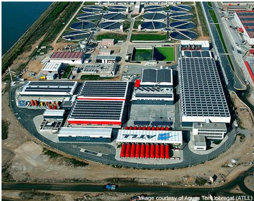
Slika 14. Prikaz postrojenja za desalinaciju vode napajanom fotonaponom u Barceloni [12]
