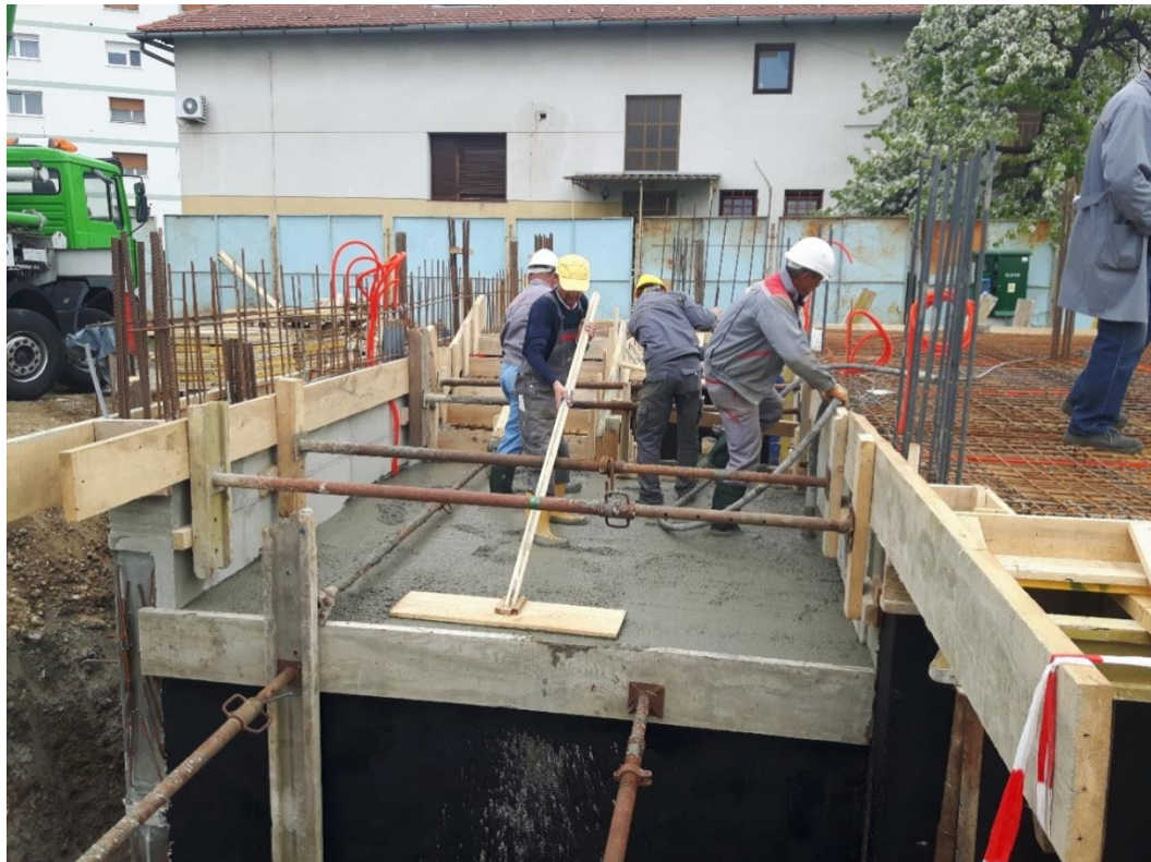
Slika 5. Betoniranje donje AB podne ploče prizemlja
