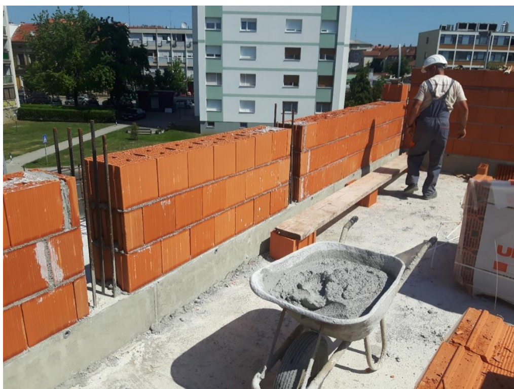
Slika 6. Zidanje nosivih zidova prizemlja
