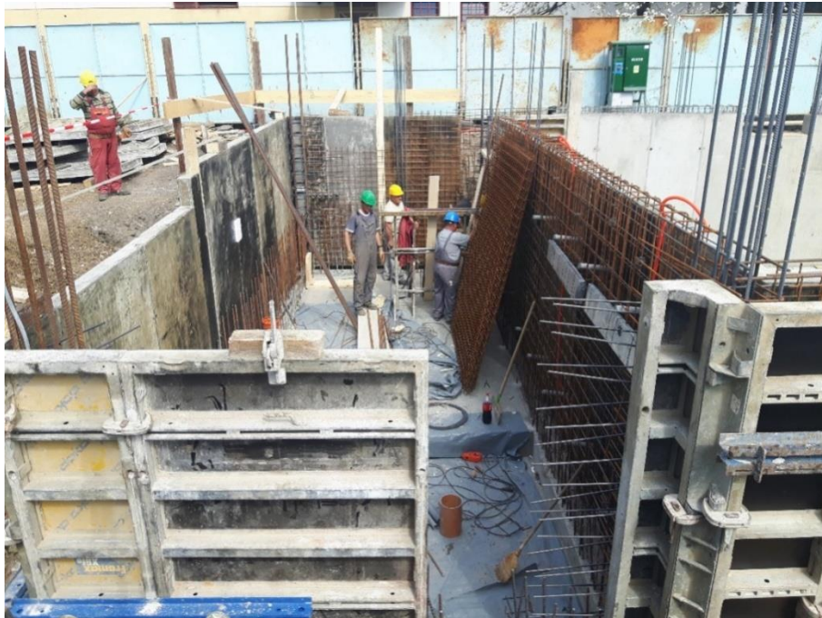
Slika 9. Oplata vertikalnih zidova podruma
