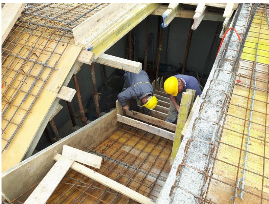
Slika 10. Izrada oplate stubišta podruma
