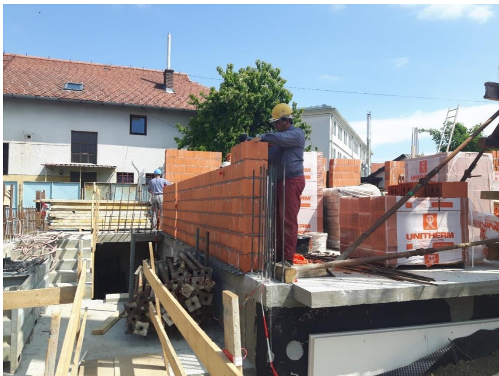
Slika 6. Zidanje nosivih zidova prizemlja
