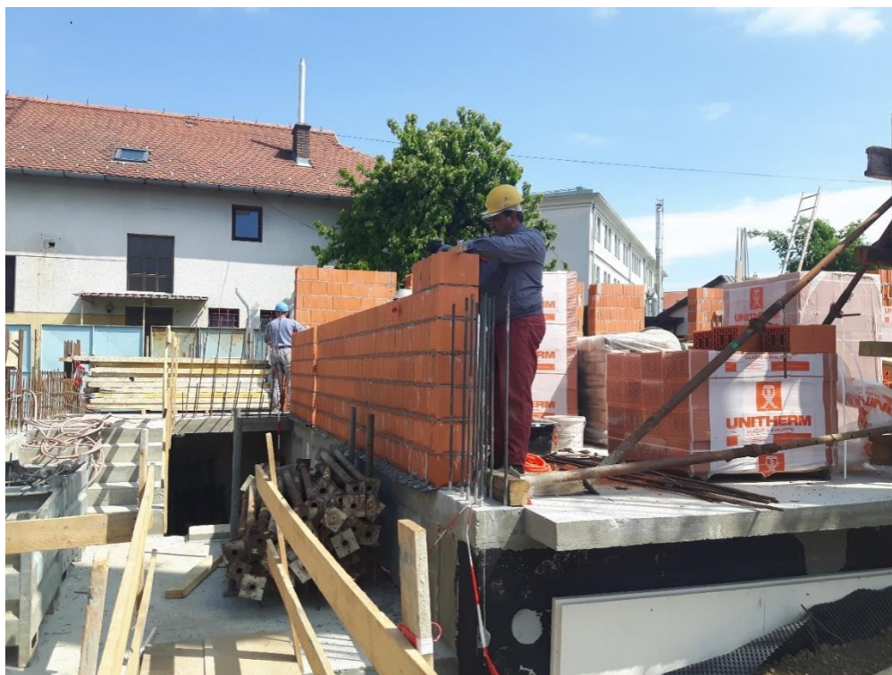
Slika 6. Zidanje nosivih zidova prizemlja
