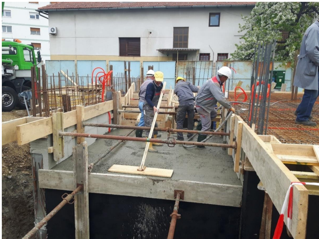
Slika 5. Betoniranje donje AB podne ploče prizemlja
