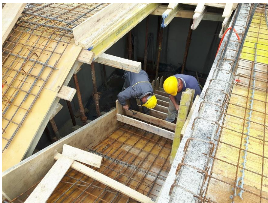
Slika 10. Izrada oplate stubišta podruma
