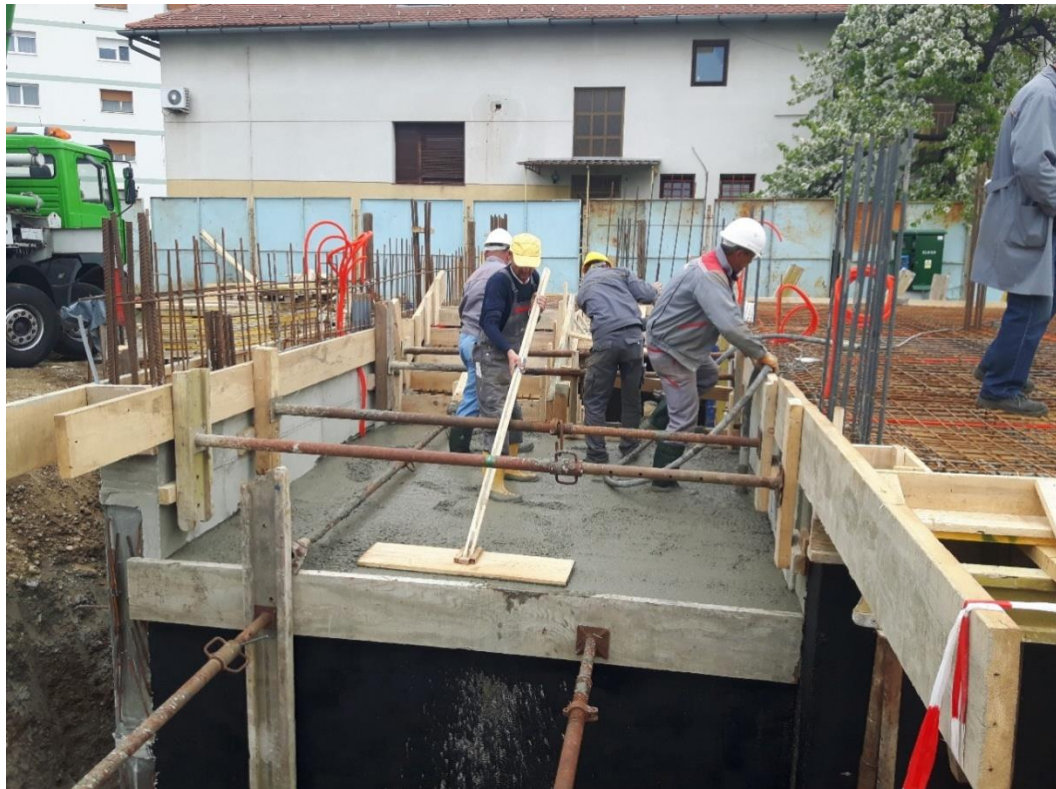
Slika 5. Betoniranje donje AB podne ploče prizemlja
