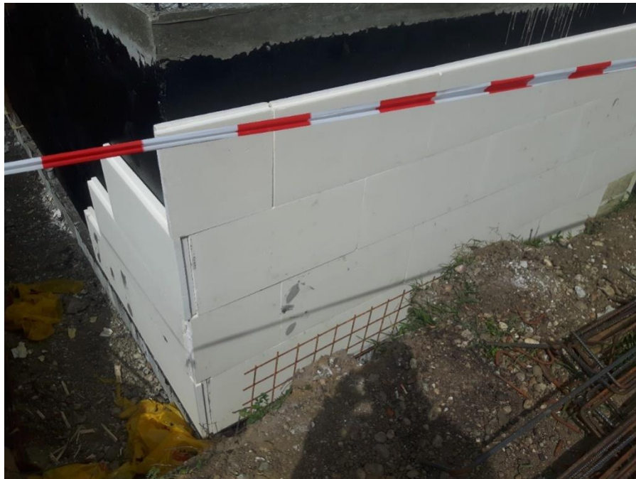
Slika 8. Izrada hidroizolacije i toplinske izolacije vertikalnih zidova podruma
