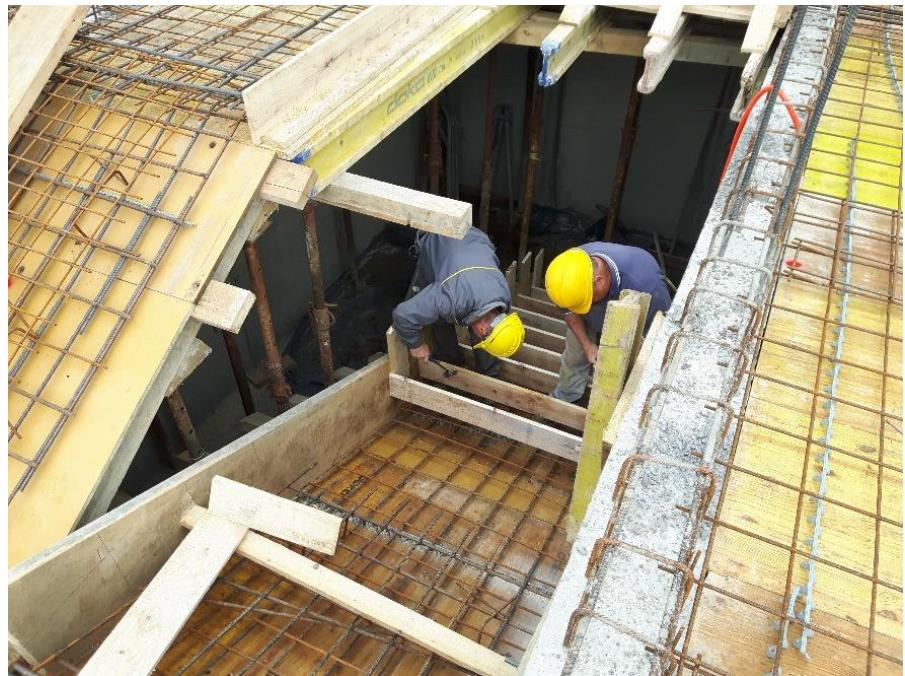
Slika 10. Izrada oplate stubišta podruma
