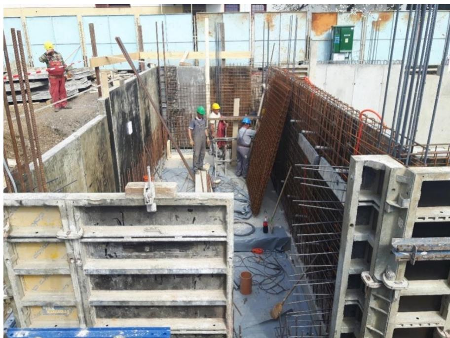
Slika 9. Oplata vertikalnih zidova podruma
