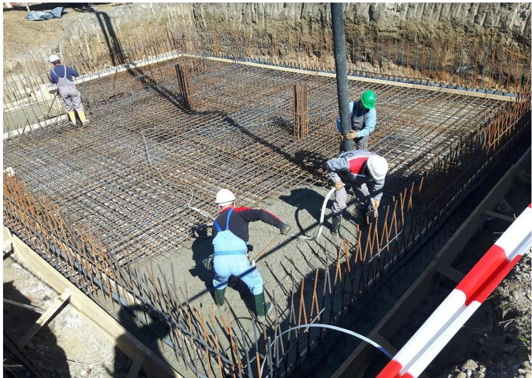
Slika 4. Betoniranje donje podložne AB ploče podruma
