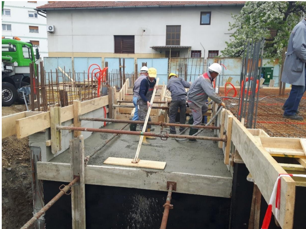
Slika 5. Betoniranje donje AB podne ploče prizemlja
