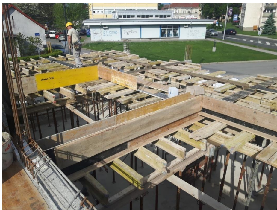
Slika 11. Izrada glatke oplate AB stropne ploče nad prizemlje
