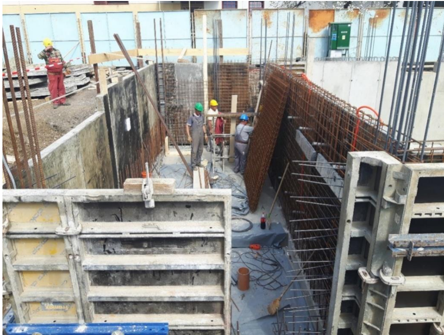
Slika 9. Oplata vertikalnih zidova podruma
