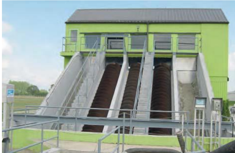
Slika 4. Stari uređaj za pročišćavanje [12]
