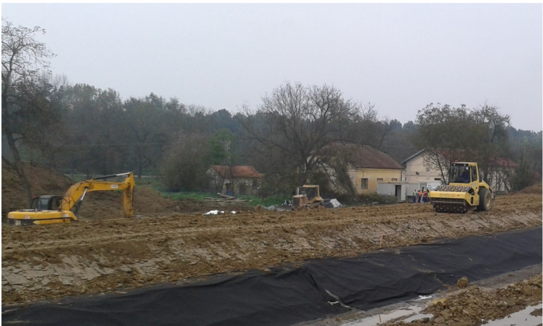
Slika 21. Zbijanje tla ježom pri gradnji nasipa
