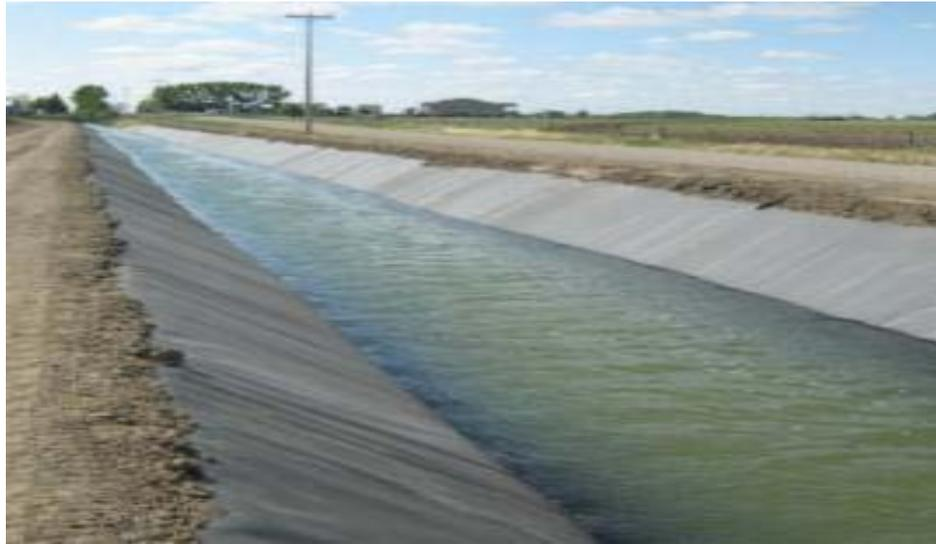
Slika 8. Obloga od plastičnih sintetičkih folija (geomembrana) [12]
