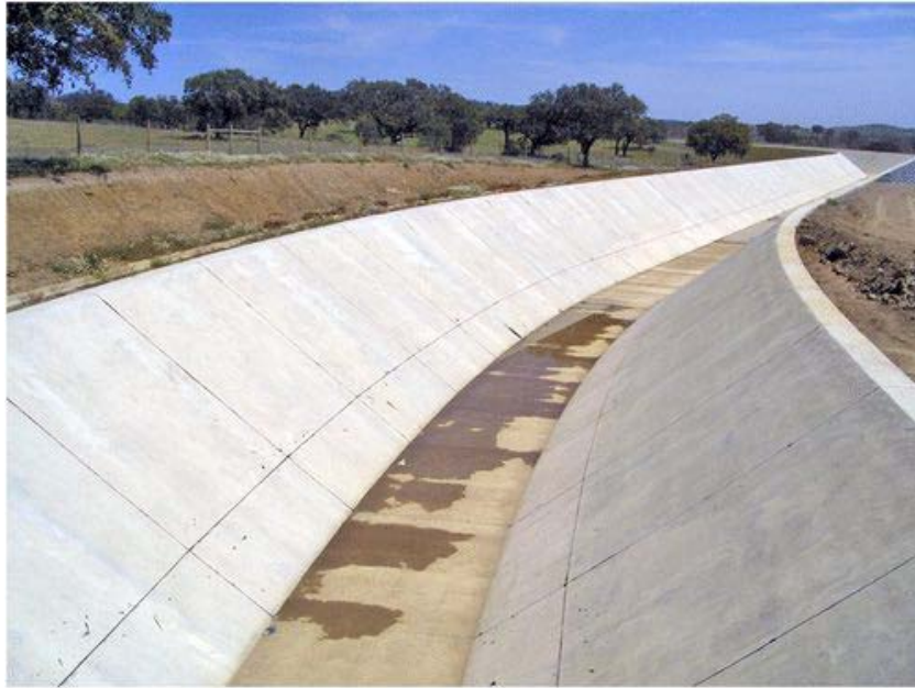
Slika 7. Betonska obloga kanala [11]
