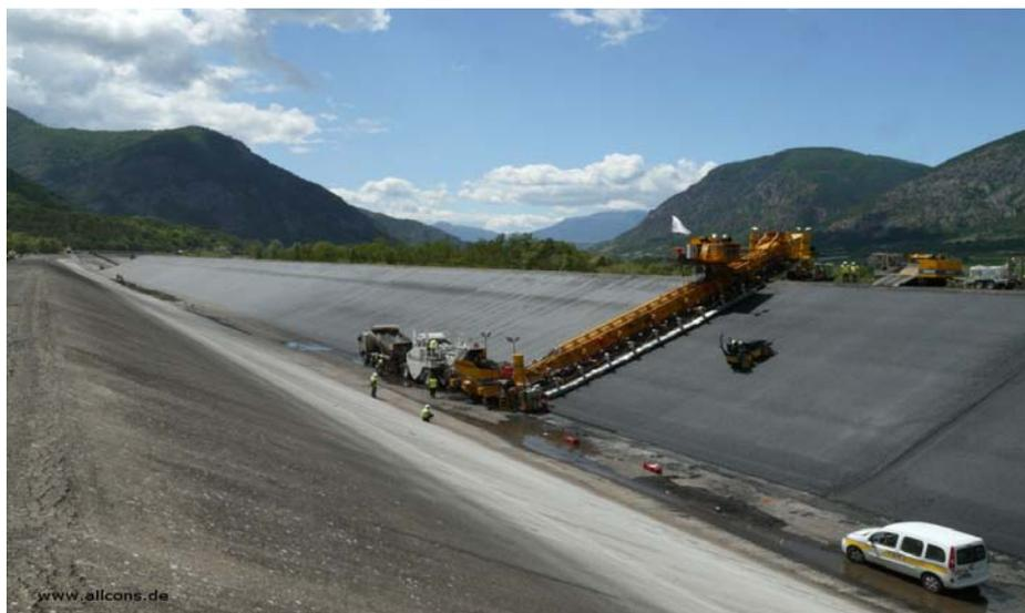
Slika 6. Asfaltbetonska obloga kanala [10]
