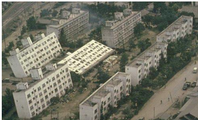
Slika 9. Posljedice pojave likvefakcije nakon potresa u Niigati, Japan, 1964. (Szavits-Nossan, 1996b)
