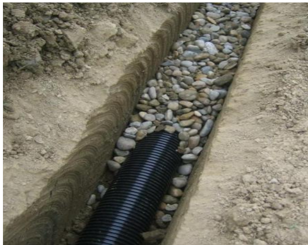
Slika 9. Drenažni sustav ( https://www.emajstor.hr/clanak/23/Drenaza_izvedba_cijena )
