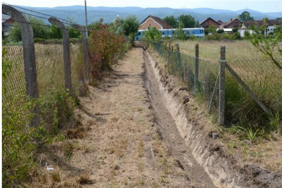
Slika 3. Odvodni jarak (trapeznog oblika) ( https://www.zagorje-international.hr/index.php/2017/07/26/iskopan-odvodni-jarak-u-ulici-grofova-orsic-koji-ce-sprijeciti-daljnje-poplavljivanje-kuca-uslijed-vecih-oborina/ )
