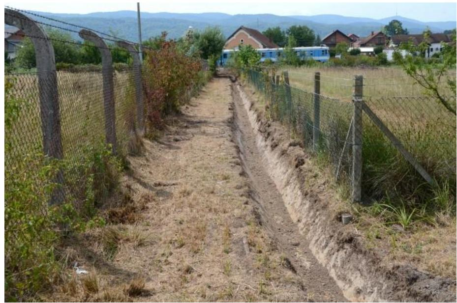
Slika 3. Odvodni jarak (trapeznog oblika) (<https://www.zagorje-international.hr/index.php/2017/07/26/iskopan-odvodni-jarak-u-ulici-grofova-orsic-koji-ce-sprijecliti-daljne-poplavljanje-kuca-uslijed-vecih-oborina/>)
