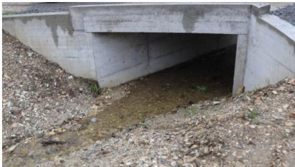
Slika 15. Pločasti betonski propust
