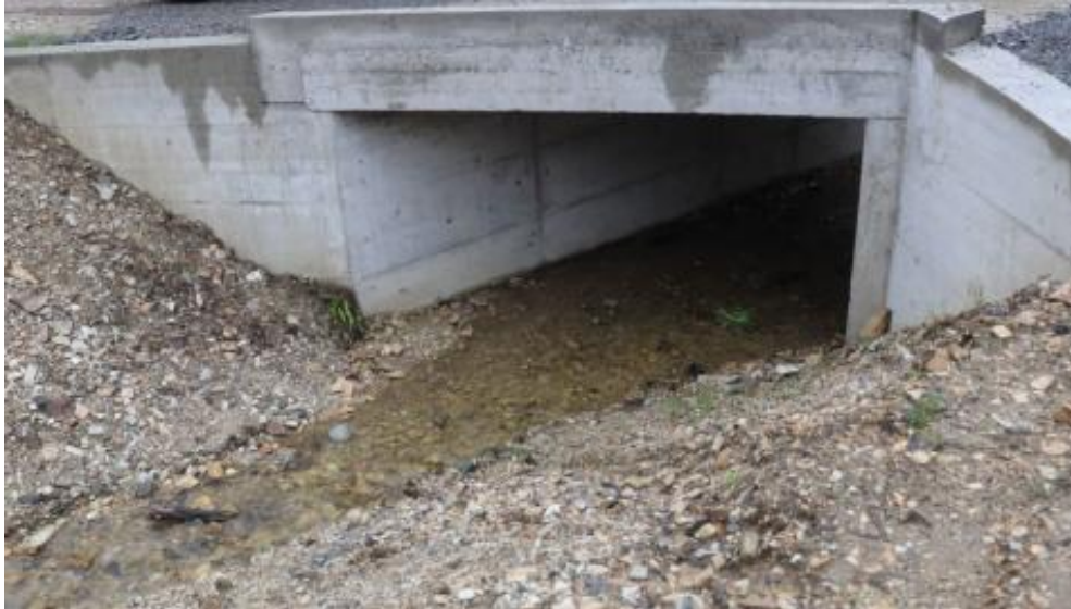
Slika 15. Pločasti betonski propust
