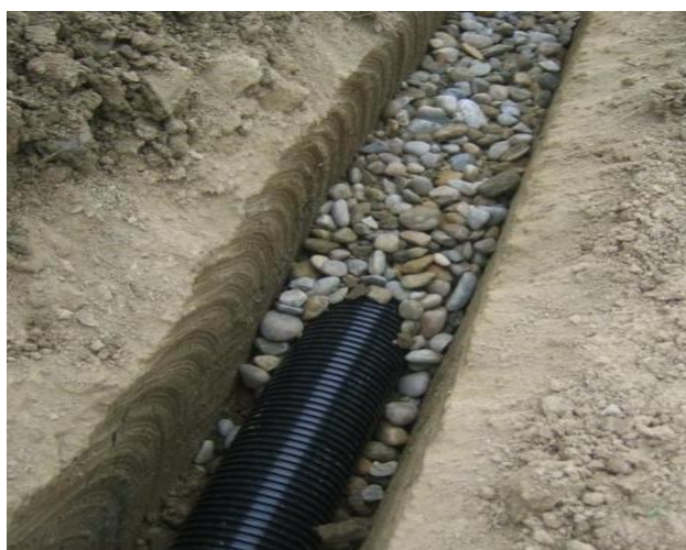
Slika 9. Drenažni sustav ( https://www.emajstor.hr/clanak/23/Drenaza_izvedba_cijena )
