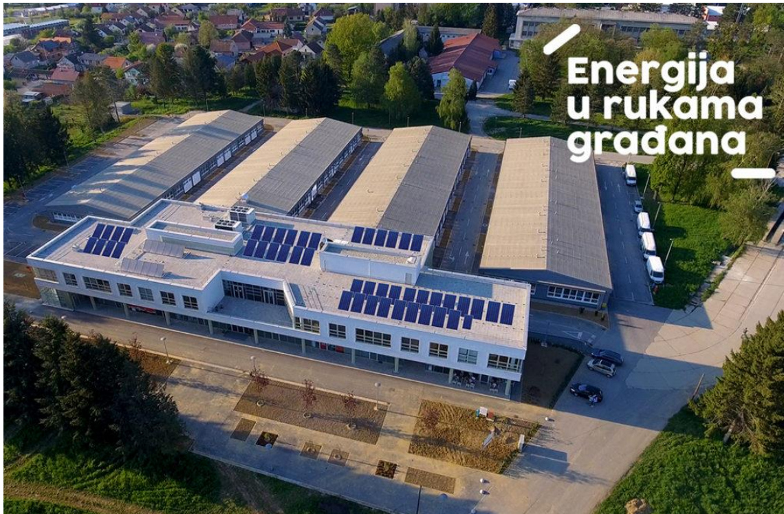
Slika 14. Prikaz implementacije PV panela na krov Razvojnog centra i tehnološkog parka Križevci [31]
