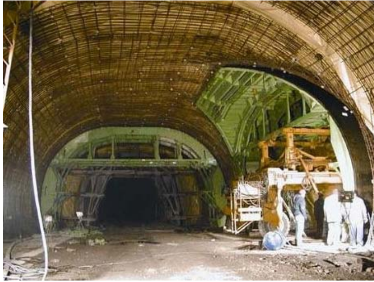
Slika 9.5 Spajanje dijela okretišta [12]
