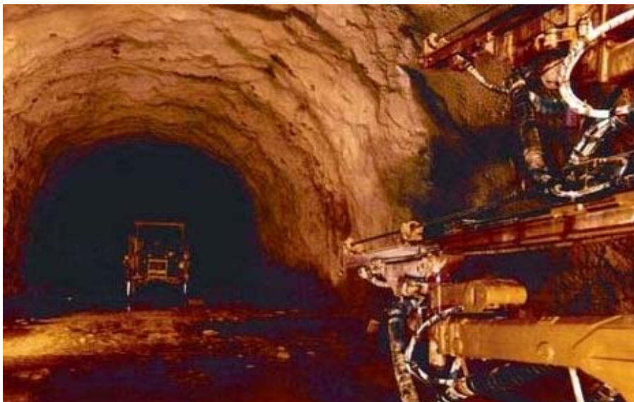
Slika 9.4 Iskop tunela Sveti Rok [12]
