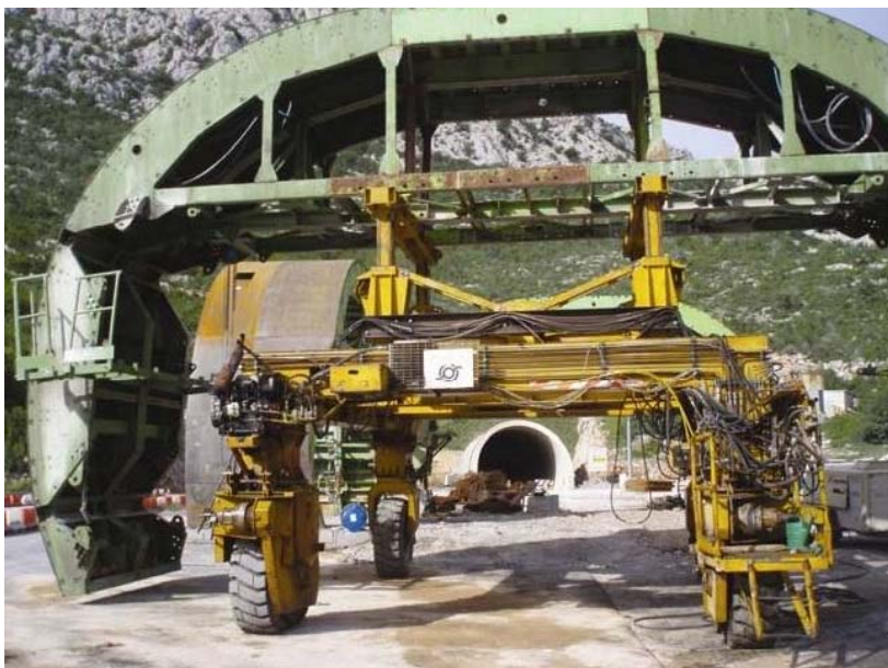
Slika 9.8 Samohodna hidraulična oplata [10].
