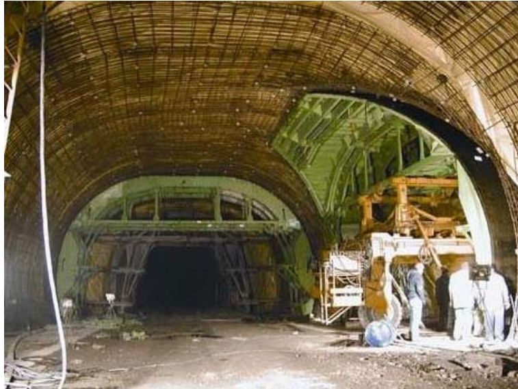
Slika 9.5 Spajanje dijela okretišta [12]
