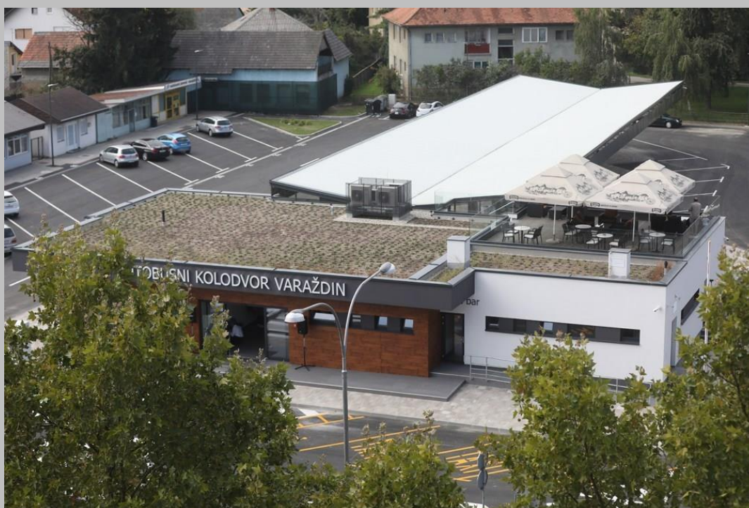
Slika 13. Zeleni krov na autobusnom kolodvoru Varaždin [22].
