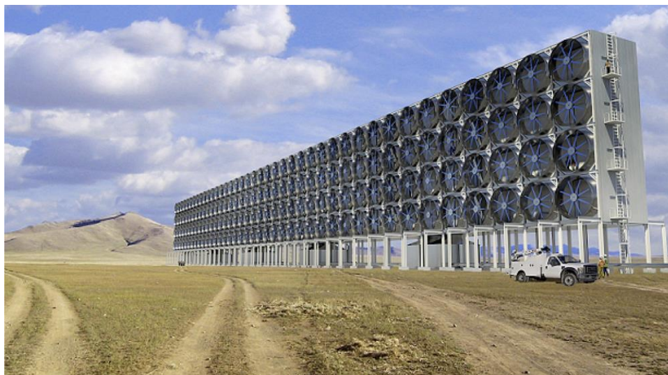
Slika 33. Uređaj za hvatanje zraka predložen od strane Carbon Engineering-a za direktno hvatanje ugljikovog dioksida iz zraka [30]
