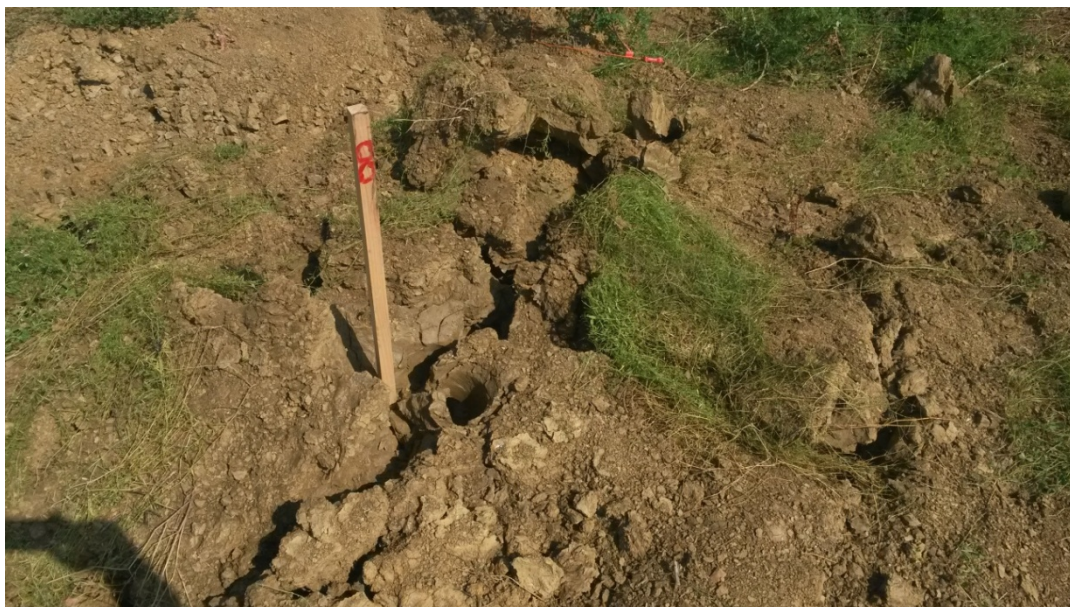
Slika 7.7 Neželjeni lijevak u obliku kratera.
