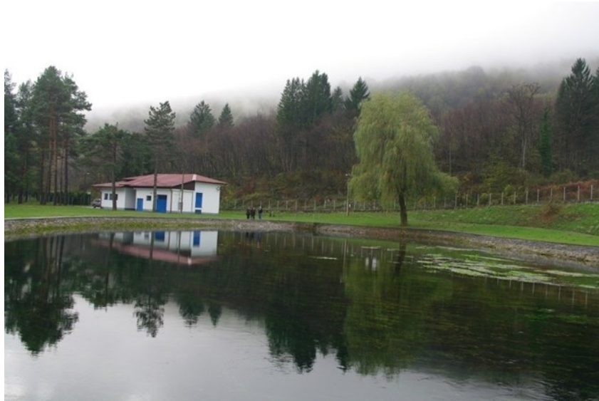
Slika 1. Crpna stanica i izvor Zagorske Mrežnice [1]
