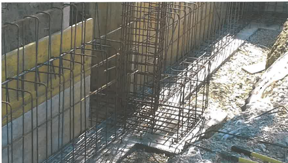
Slika 4. Prikaz temeljne konstrukcije.
