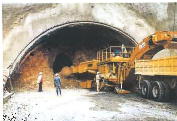
Slika 7.2. Stroj sa pokretnom glavom [5].
