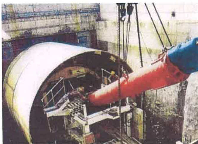
Slika 8.4. Montaža štita u tvornici i postavljanje pužastog transportera u polazno okno na gradilištu u Milanu [15].
