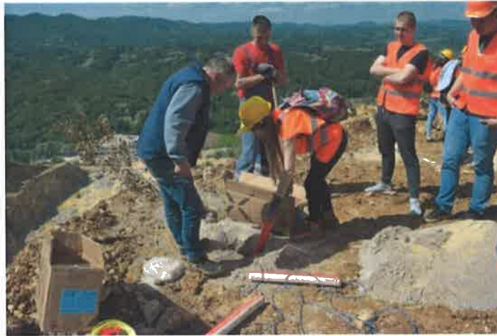
Slika 4.4. Punjenje minske bušotine eksplozivom. [16].
