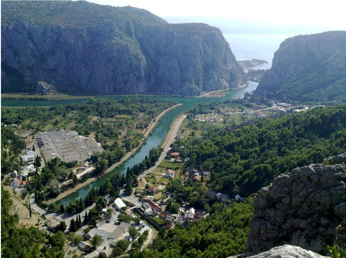
Slika 7. Hidroelektrana Zakučac (HEP.hr)
