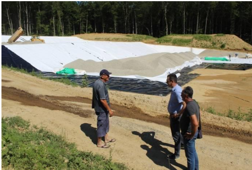
Slika 9 Sanacija odlagališta otpada Ivančino brdo [16]
