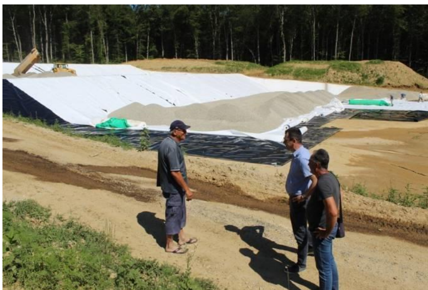
Slika 9 Sanacija odlagališta otpada Ivančino brdo [16]
