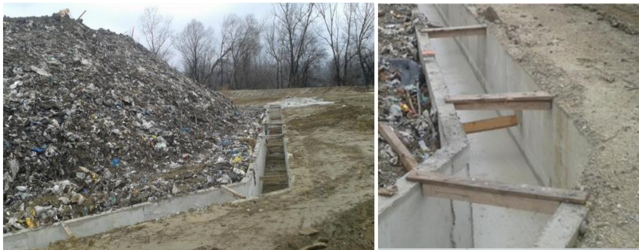
Slika 13. i 14. Prikaz uvodnog kanala
