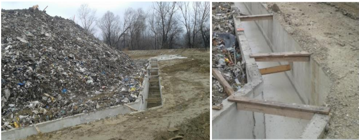
Slika 13. i 14. Prikaz uvodnog kanala
