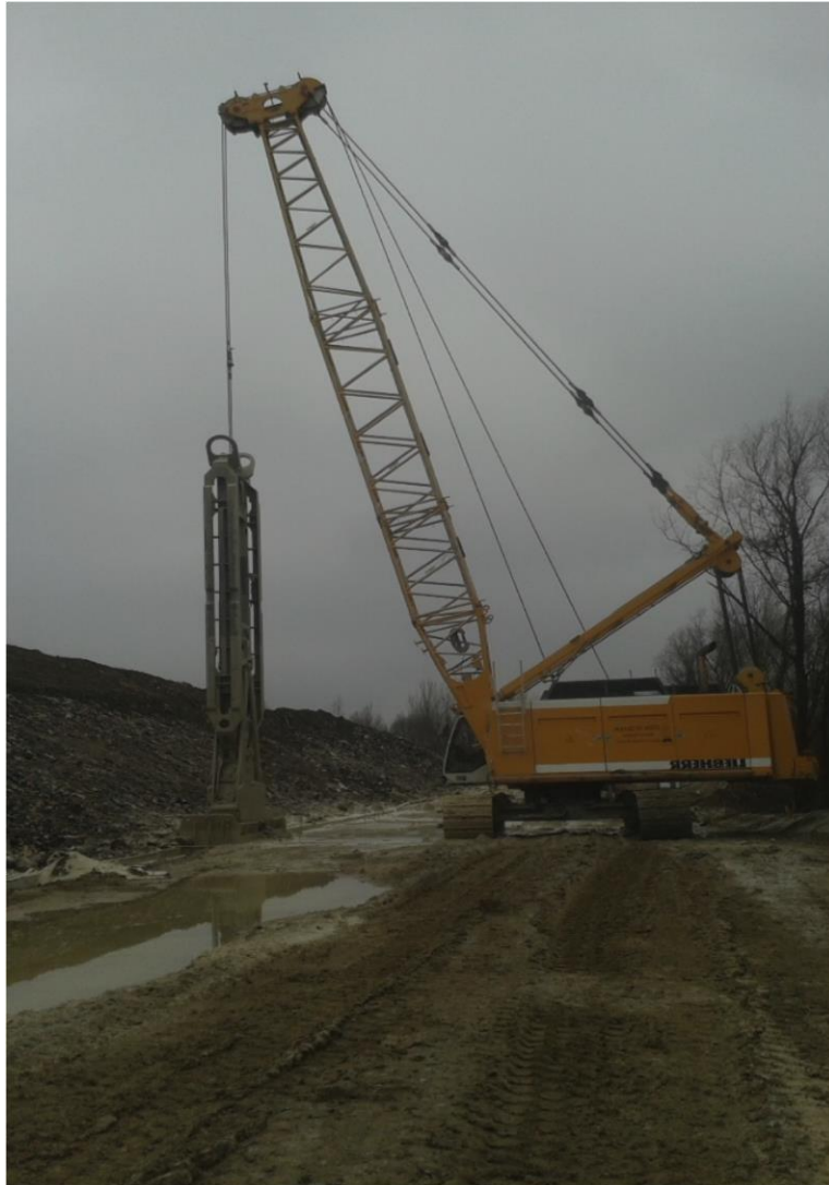
Slika 16. Bager s obješenom grabilicom tijekom iskopa dijafragme na odlagalištu Trebež
