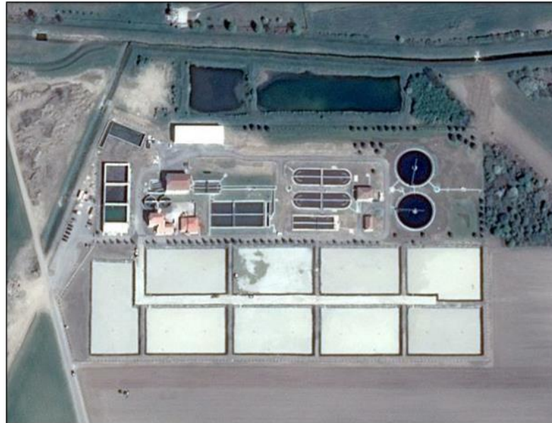
Slika 2. Uređaj za pročišćavanje otpadnih voda Čakovec [5]
