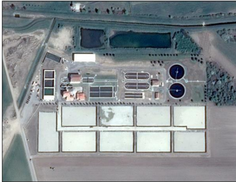
Slika 2. Uređaj za pročišćavanje otpadnih voda Čakovec [5]
