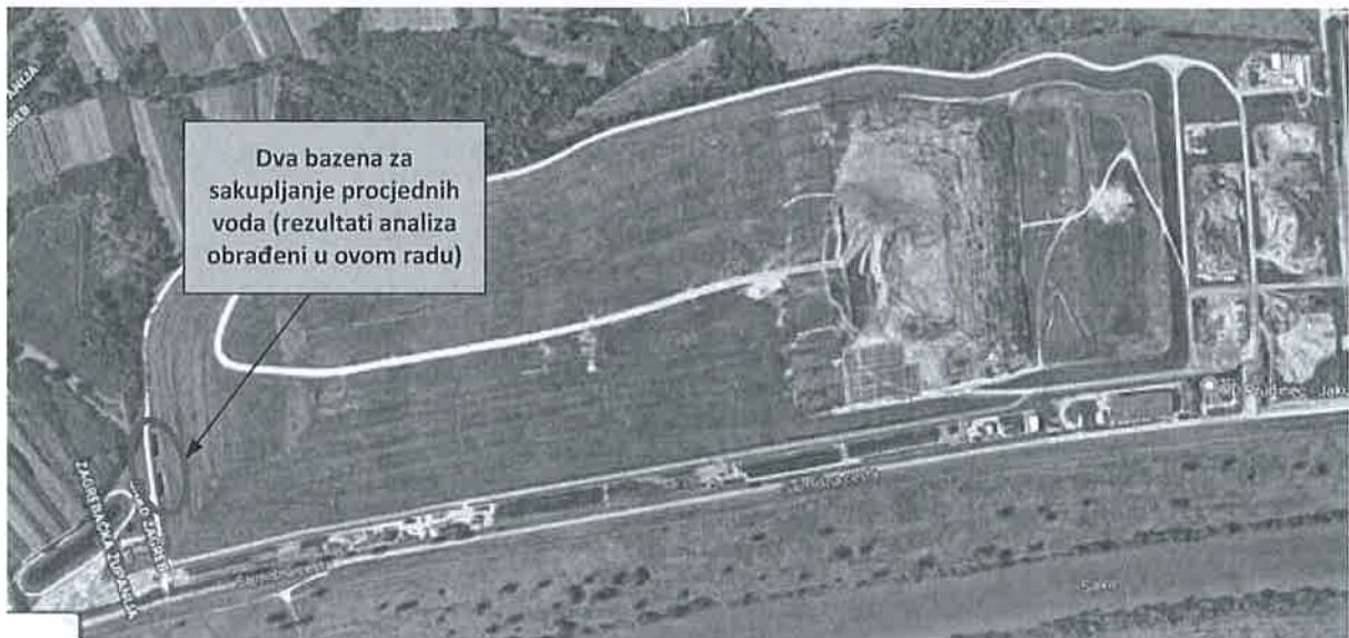
Slika 13. Procjedni bazeni na odlagalištu Prudinec Jakuševac
