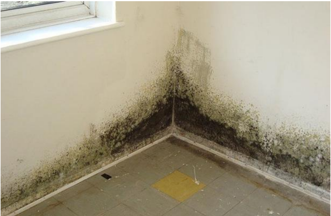
Slika 10. Gljivice i plijesan na mjestima toplinskih mostova [14]
