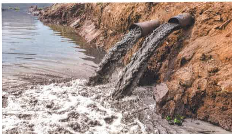
Slika 11 Ispuštanje onečišćene vode u vodotok
