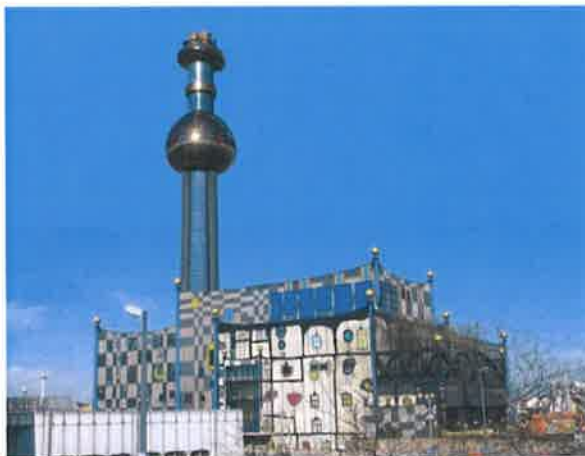
Slika 17. Spittelau, energana za otpad za proizvodnju toplinske energije u Beču
