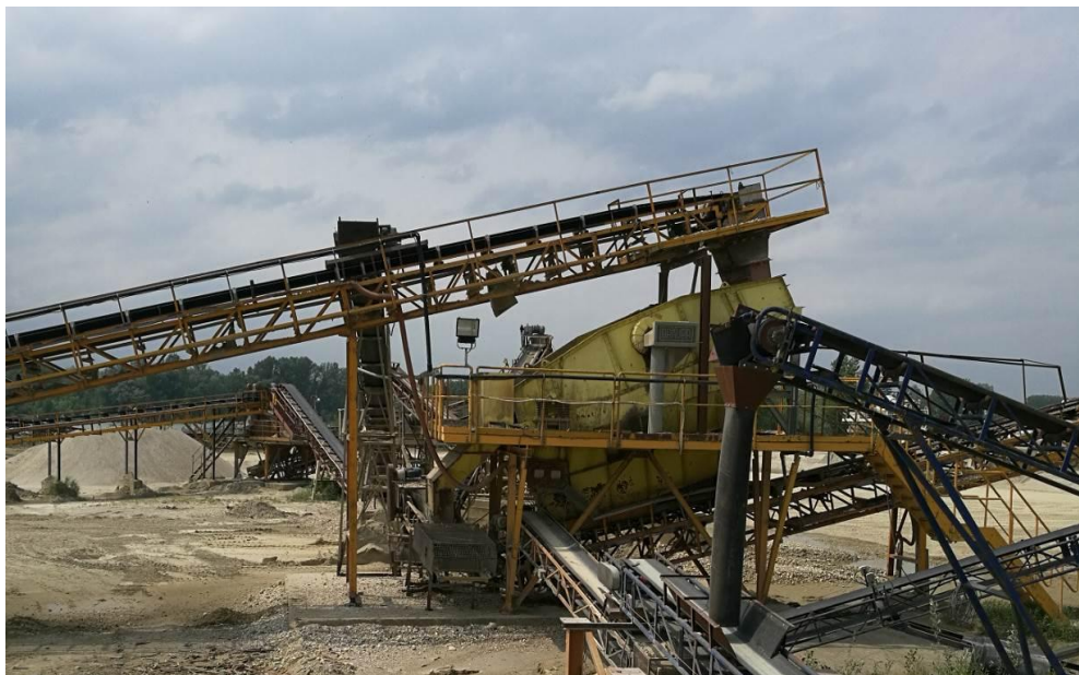
Slika br. 14: Primarno vibracijsko sito [10]
