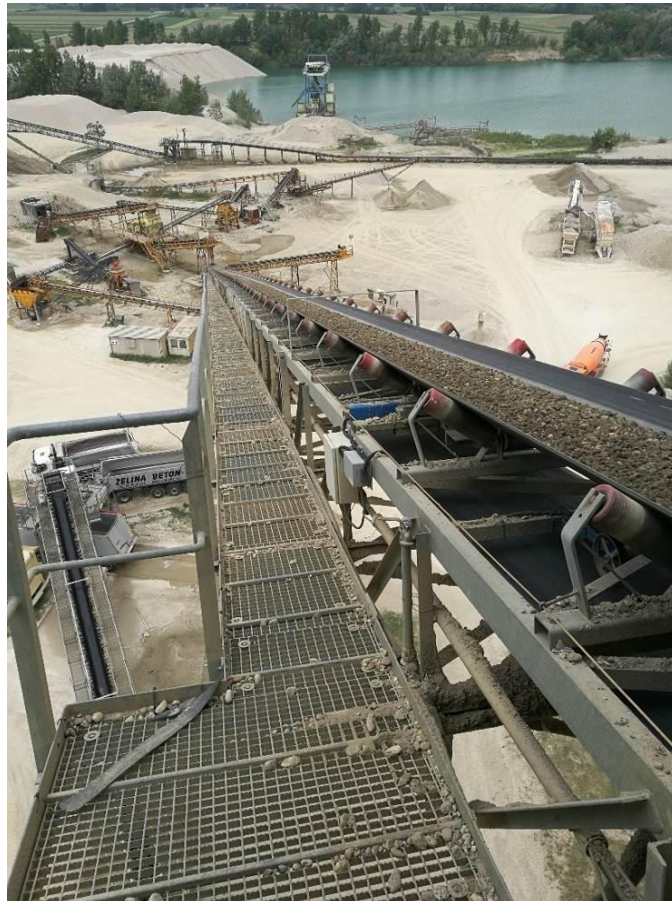
Slika br. 7 Transportna traka prema primarnom separacijskom postrojenju [10]
