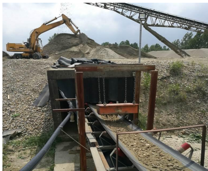
Slika br. 12: Izlaz iz separacijskog tunela [10]
