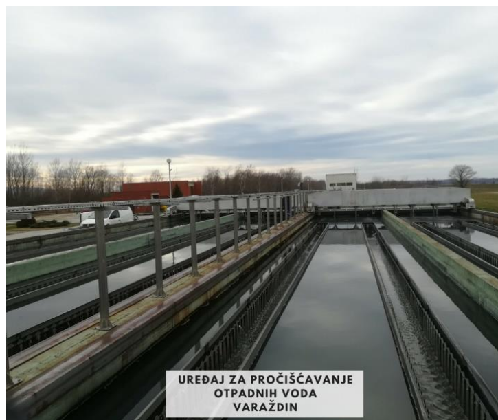
Slika 15. Uređaj za pročišćavanje otpadnih voda Varaždin [23]
