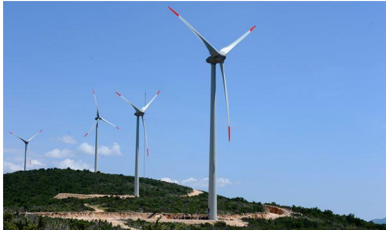
Slika 10. Vjetroelektrana s vodoravnim rotorom [22]
