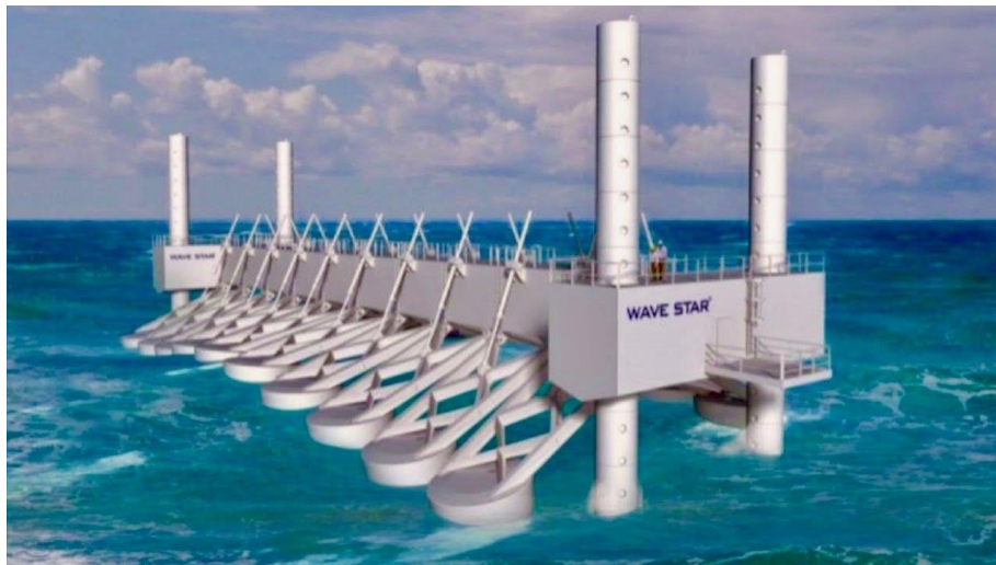
Slika 5. Sustav za pretvaranje energije valova u električnu [13]
